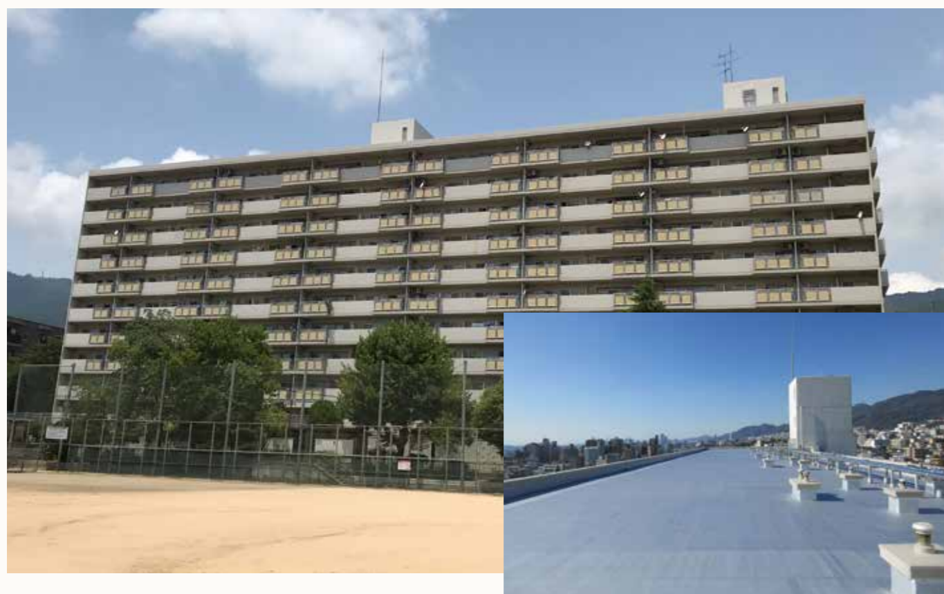
兵庫県営神戸楠丘高層住宅 加硫ゴム系シート防水接着工法
