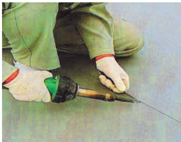
熱風溶接機による熱融着
