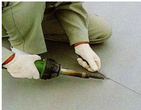
熱風溶接機による熱融着
