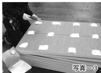
写真-3 湿気硬化型接着剤の塗布
