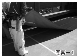
写真-1 剥離フィルム無しの接着剤付きシート防水材による施工
