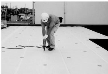
写真-2 先付け固定工法
