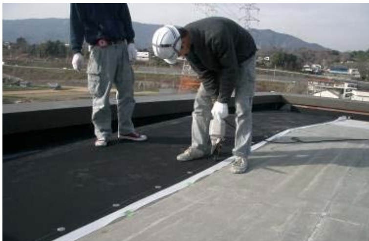
機械的固定工法の施工状況
