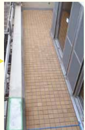
保護モルタル 10mm程度 +新設タイル
