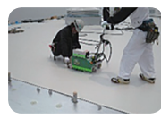
熱可塑性エラストマー系 シートの敷設
