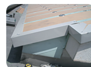
軒先部固定金具の設置
