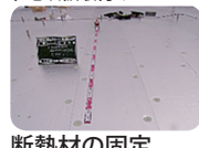
断熱材の固定
