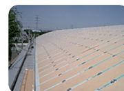
断熱材の固定
