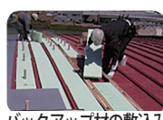
バックアップ材の敷込み 下地鉄板取付け
