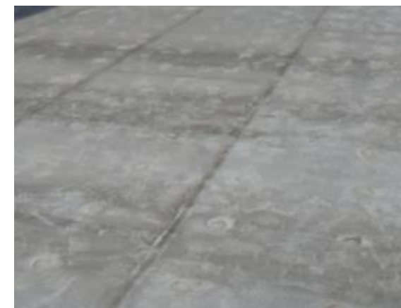
劣化度Ⅰ 損傷無し
