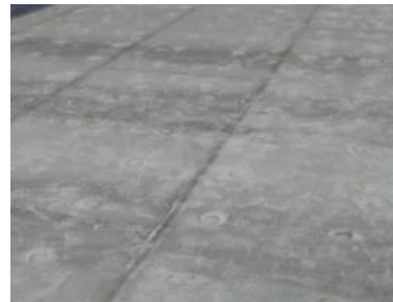
劣化度Ⅰ 損傷無し
