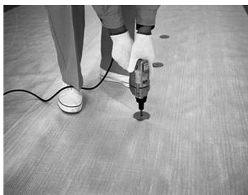
写真1 機械的固定工法
