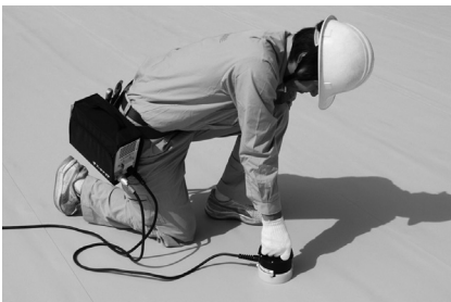
写真1 高周波溶着機による熱融着
