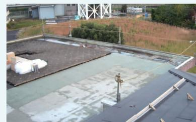
既設ルーフブロック撤去・接着工法下地処理状況
