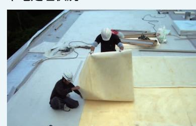
接着断熱工法シート張り状況
