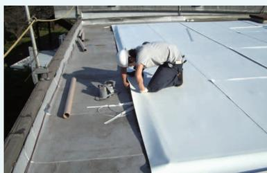
高反射率シートを使用した機械的固定断熱工法部
