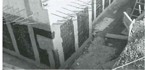
地下外壁（後やり工法）
