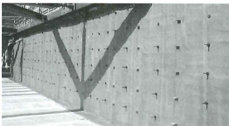
地下山留め壁（先やり工法）
