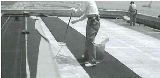
接着剤の塗布作業
